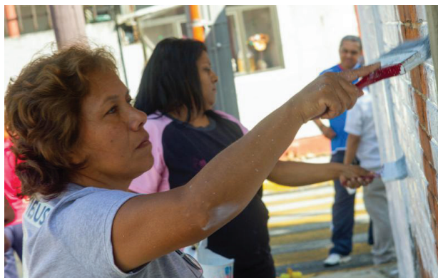
Imagen 5. Trabajos previos. Las madres del Colectivo fondeando las paredes
