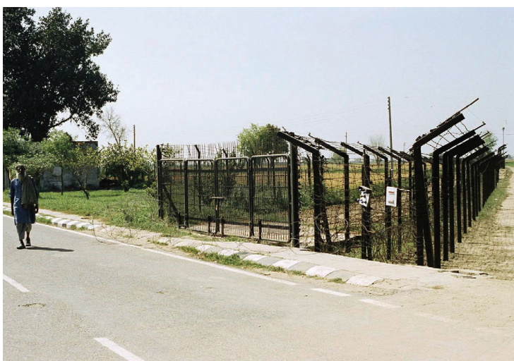
Imagen 2. La frontera electrificada. Valla electrificado en la línea divisoria. Frontera entre la India y Pakistán.
